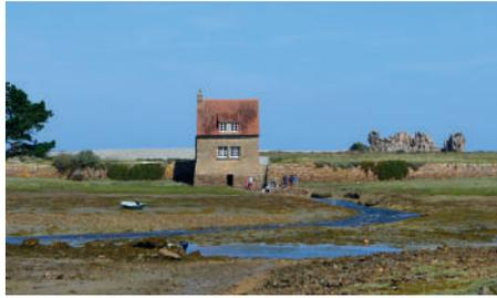
Le moulin à marée est systématiquement établi au milieu d'une digue comportant des vannes à sens unique et de deux ouvertures ou pertuis, la première laissant entrer la marée montante, tandis que la seconde, sur laquelle se trouve la roue à pales, permet de libérer l'eau quand elle redescend. Ces bâtisses sont généralement protégées des vagues, mais assez proches de l'océan afin d'obtenir une amplitude de marée suffisante.
