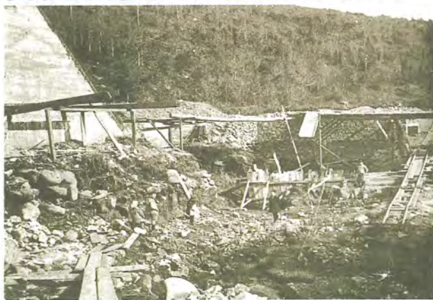
La construction du barrage de Kernansquillec (1920-1922)
