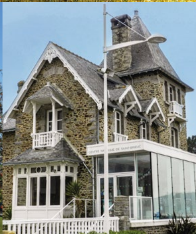
Centre nautique de Saint-Brieuc
